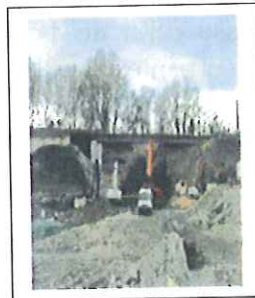
En amont de Ners, réparation du pont de la voie ferrée partiellement emporté (photo BCEOM)
