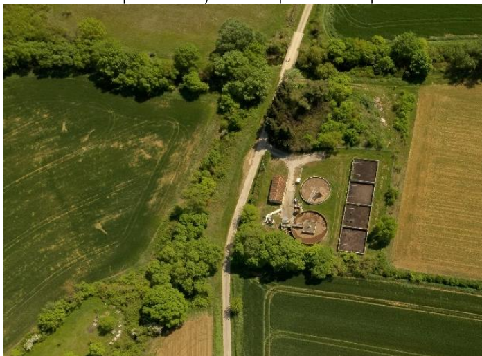
Station de Traitement des Eaux Usées (STEU) de Saint-Chaptes
