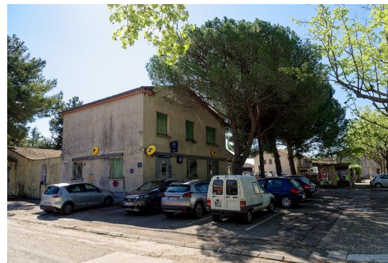
Stationnement Bureau de Poste
