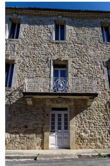
Ferronnerie remarquable sur un édifice en pierre
