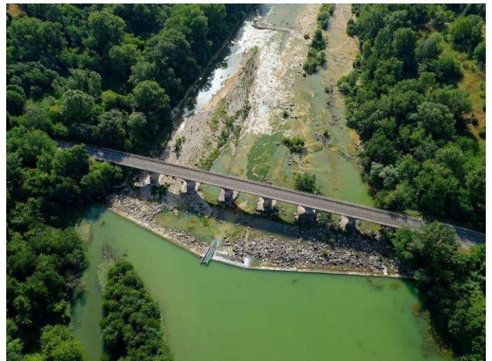
Figure 19 : vue aérienne du seuil de Saint-Chaptes (drone ASE)
