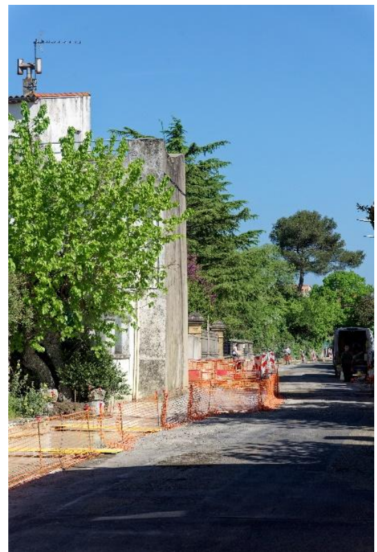
Aménagement piétonnier en travaux dans le centre
