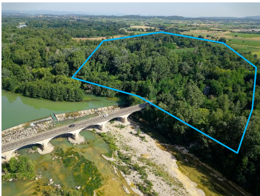
Vue aérienne sur le secteur Nra (Drone ASE)
